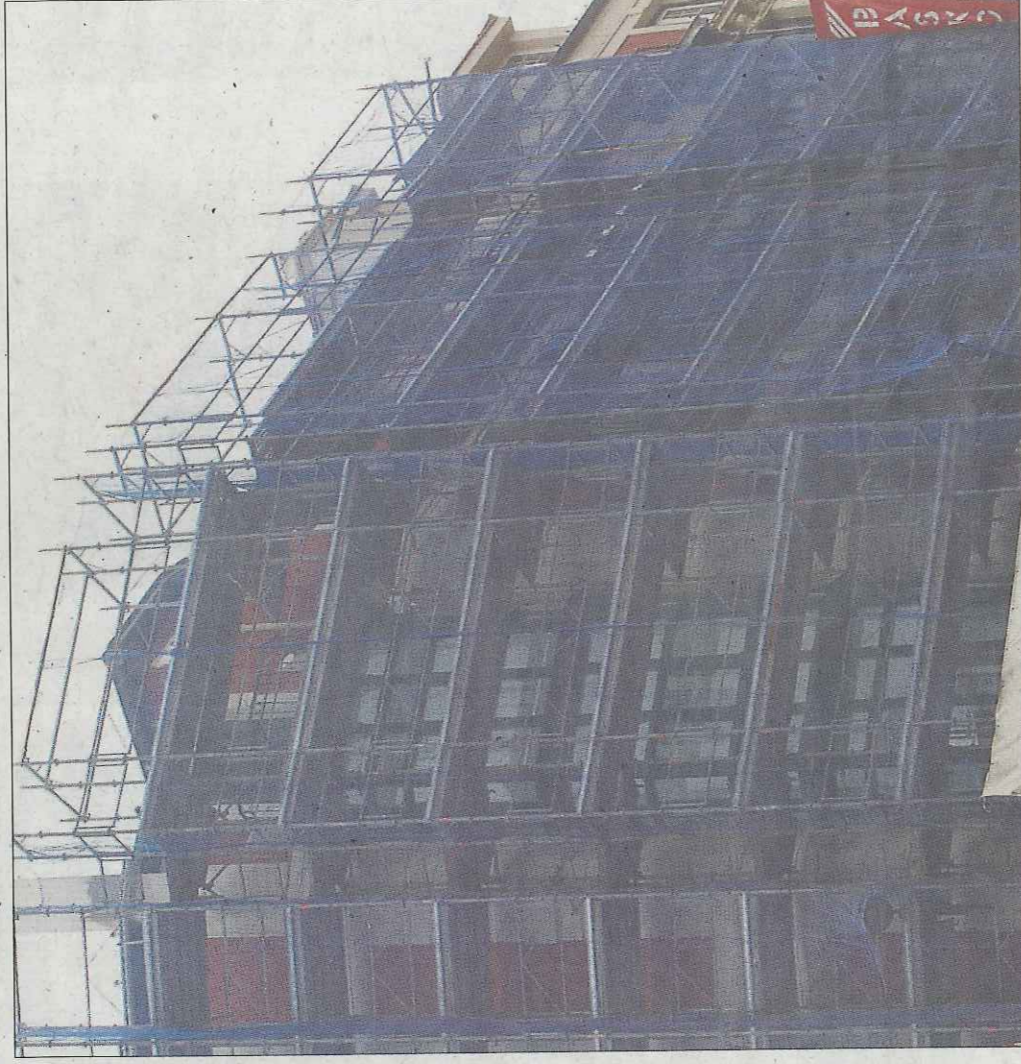
Fachada de edificio en rehabilitación. / SANTOS CIRILO
